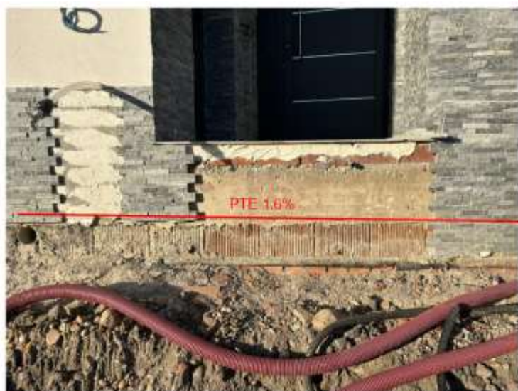
ZONA DE ACCESO A LA VIVIENDA. LG TR GABRIEL Y GALÁN S/N, ALDEHUELA DEL JERTE DIFERENCIA DE ALTURA CUERDA - ACCESO
