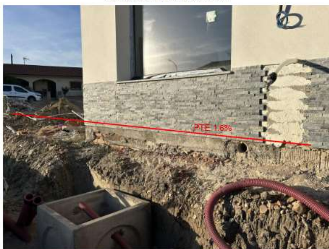
VISTA GENERAL PENDIENTE SEGÚN PROYECTO DE URBANIZACIÓN
